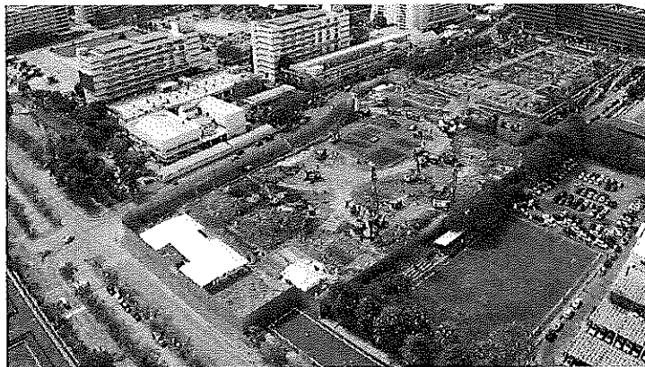
ภาพถ่าย : การก่อสร้างอาคารอาคารที่จอดรถ อาคารราชบุรีดิเรกฤทธิ์ (Depot)
